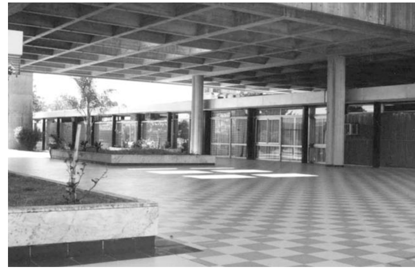
Vista de las instalaciones del Túnel.
