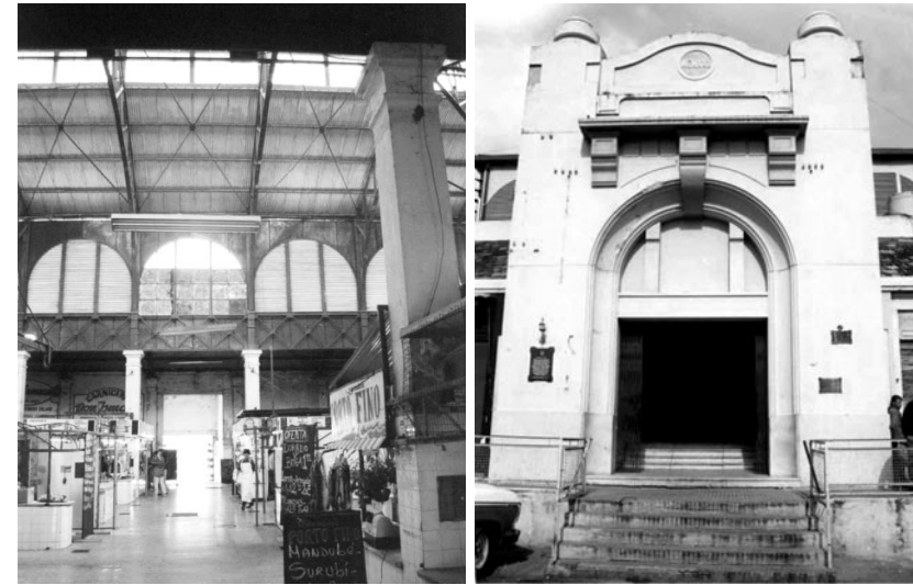
Interior | Ingreso sobre calle Venezuela
