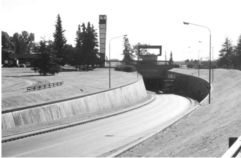
Ingreso al túnel desde Paraná.
